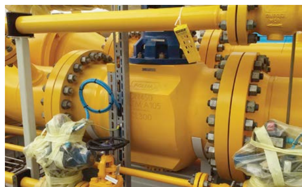
Zdj. 1: Zawór BR33-DN450 na instalacji w elektrowni w Egipcie.
